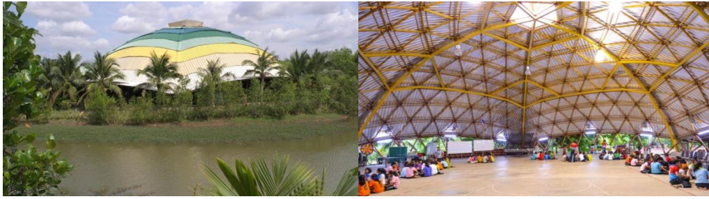
อาคารเอนกประสงค์ geodesic dome ที่สร้างด้วยไม้ไผ่
